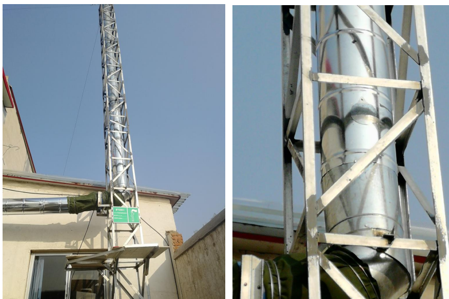
图 10-1 有组织废气取样口和标识牌
