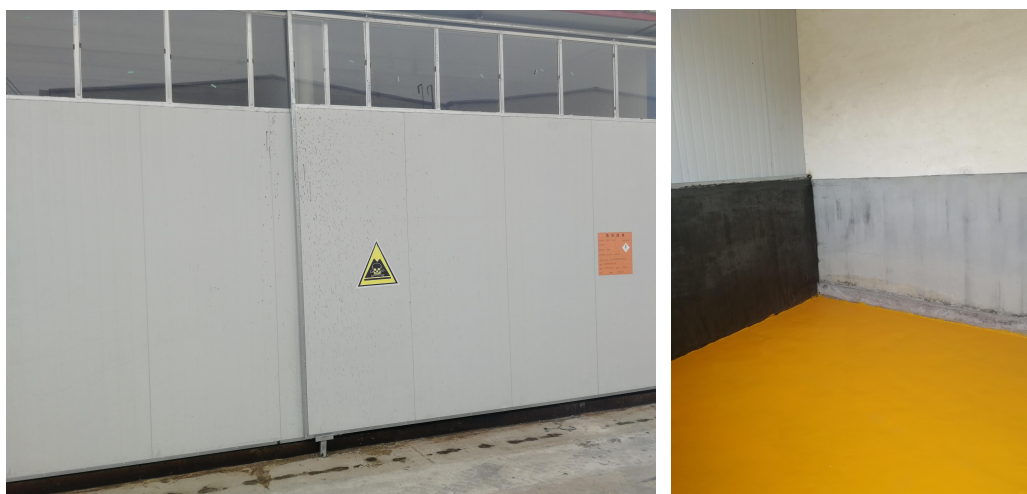
图 10-2 危废贮存间和标识牌
